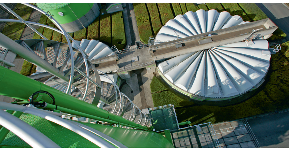
Slibtanks vanaf de slibsilos
