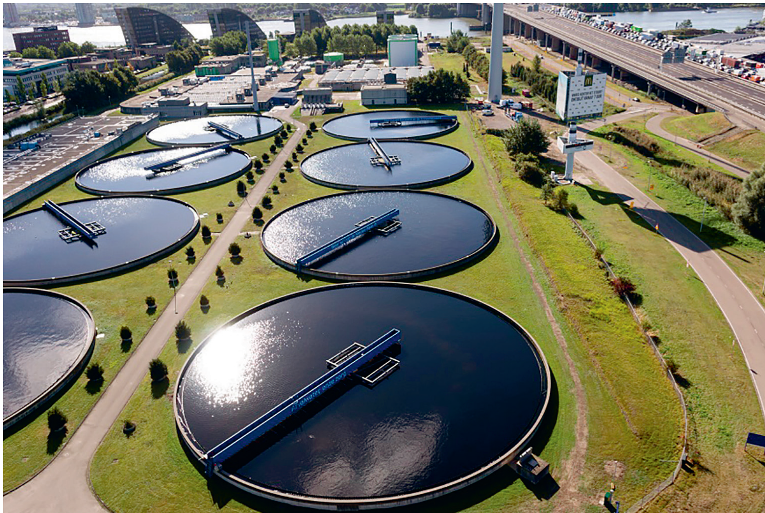
Nabezinktanks bij afvalwaterzuivering Kralingseveer in Capelle aan den IJssel
